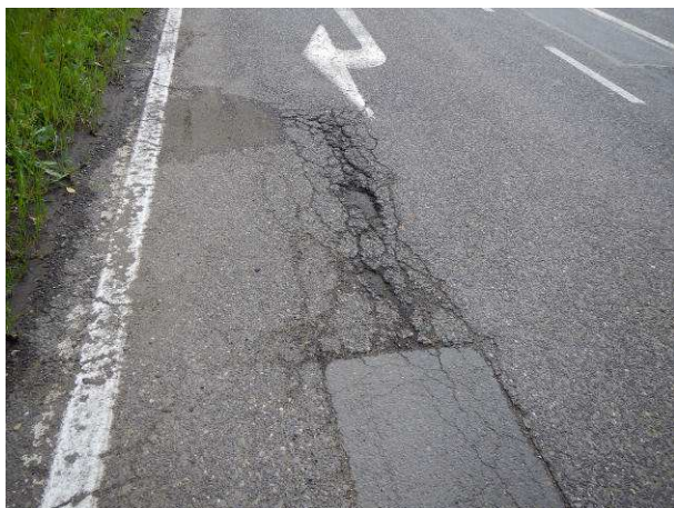
Hlubková koroze, výtluky, mozaikové trhliny, vysprávk
