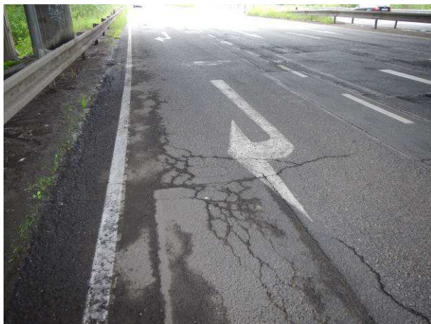
Hlubková koroze, mozaikové trhliny, vysprávk
