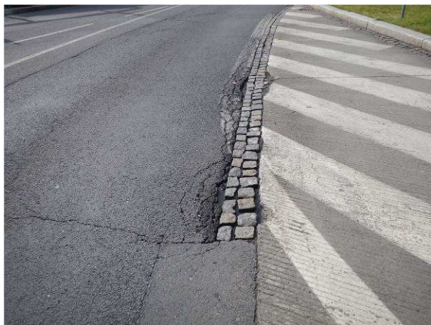
Hloubková koroze, výtluk, mozaikové trhliny, vysprávký
