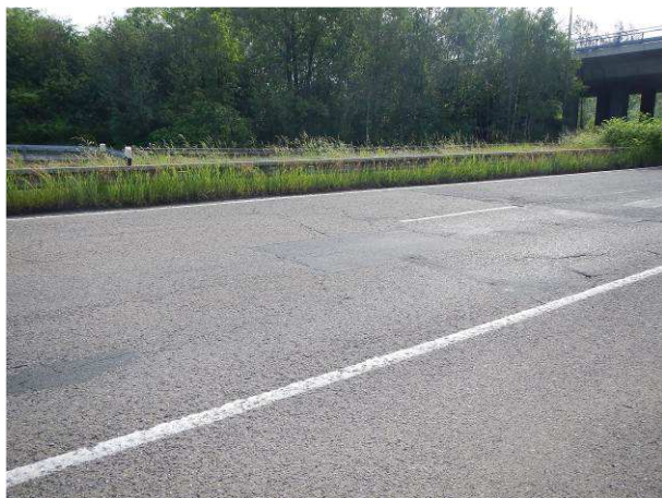
Hlubková koroze, vysprávkky, trhliny
