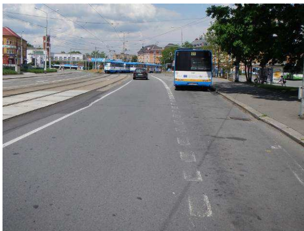
PJP – ztráta makrotextury, olejové úkapy od autobusů
