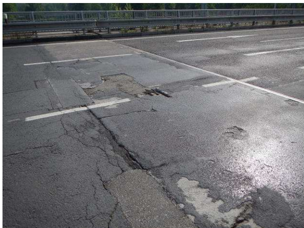
Hlubková koroze, mozaikové trhliny, vysprávkky
