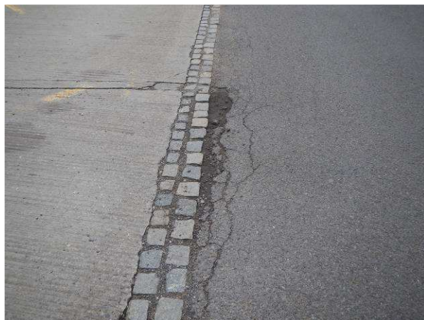
Mozaikové trhliny, hloubková koroze
