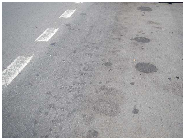
PJP – ztráta makrotextury, olejové úkapy od autobusů
