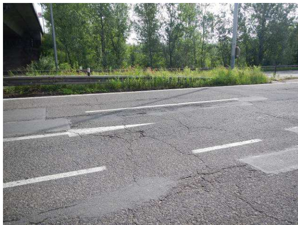
Hlubková koroze, mozaikové trhliny, vysprávk
