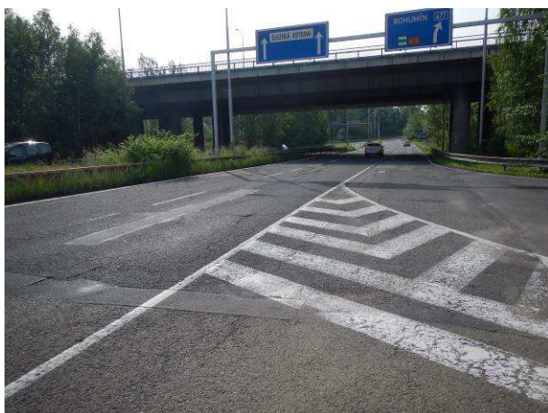
Hlubková koroze, vysprávkky, trhliny
