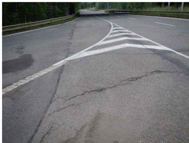
Hlubková koroze, trhliny
