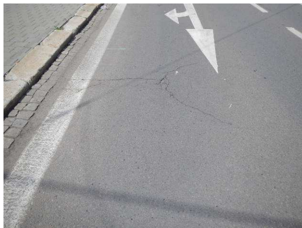
LJP – rozvětvená příčná trhлина, ztráta makrotextury
