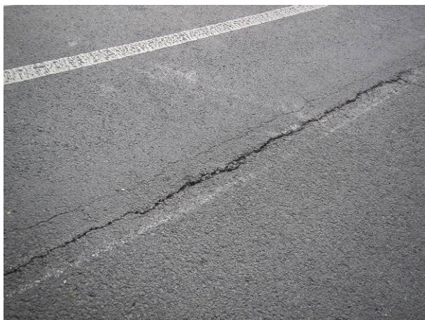
Podélná rozvětvená trhlina
