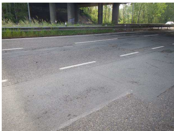
Hlubková koroze, vysprávkky, trhliny
