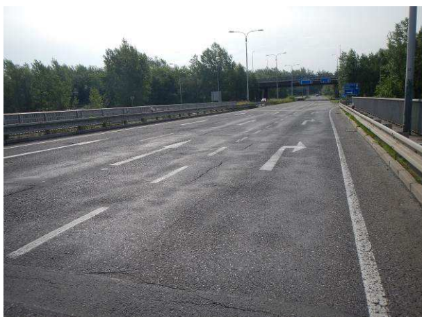
Hlubková koroze, trhliny, vysprávkky
