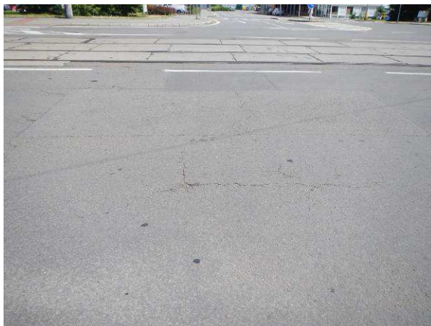
LJP – začínající mozaikové trhliny, hloubková koroze
